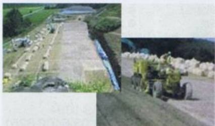
吸着層施工現場写真
