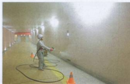
地下連絡通路防カビ対策作業
